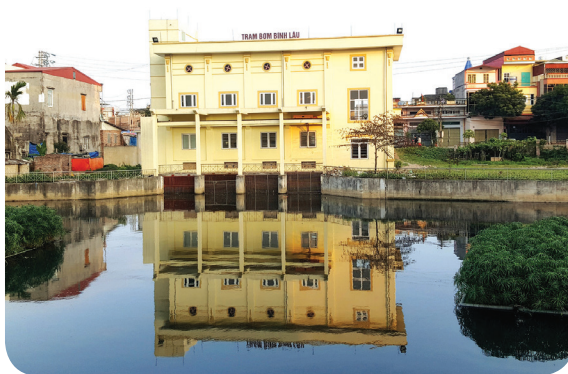
Hình 1c. Trạm bơm Bình Lâu (thành phố Hải Dương)
