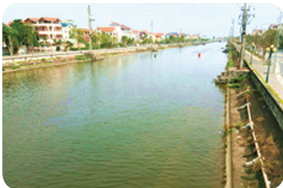
Hình 1d. Bờ kè sông Cầu Cát (thành phố Hải Dương)
