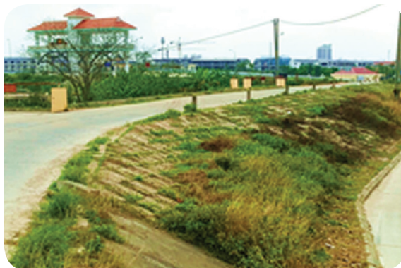
Hình 1e. Kiên cố hoá đê sông Thái Bình (thành phố Hải Dương)
